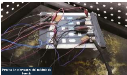
Prueba de sobrecarga del módulo de batería
